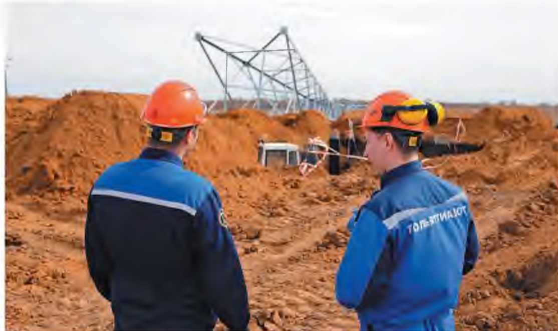
Тольяттиазот поможет строителям дороги электроэнергией
